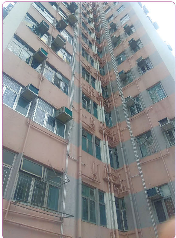
△ 完成更換大廈外牆食水管工程
